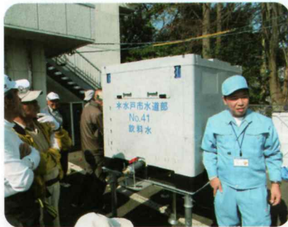
給水タンク組立て完成
