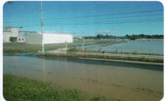
浸水した畑地区（JAライスセンター付近）
