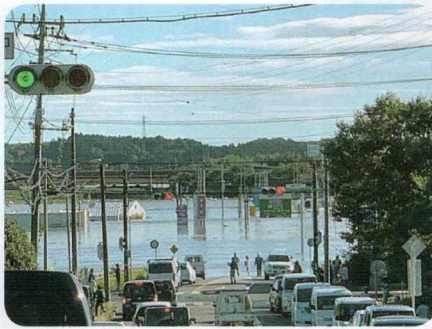
水没した123号線（最大7m以上浸水）
